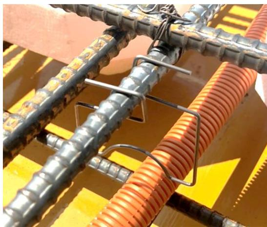
④ CD管と鉄筋を結束する
